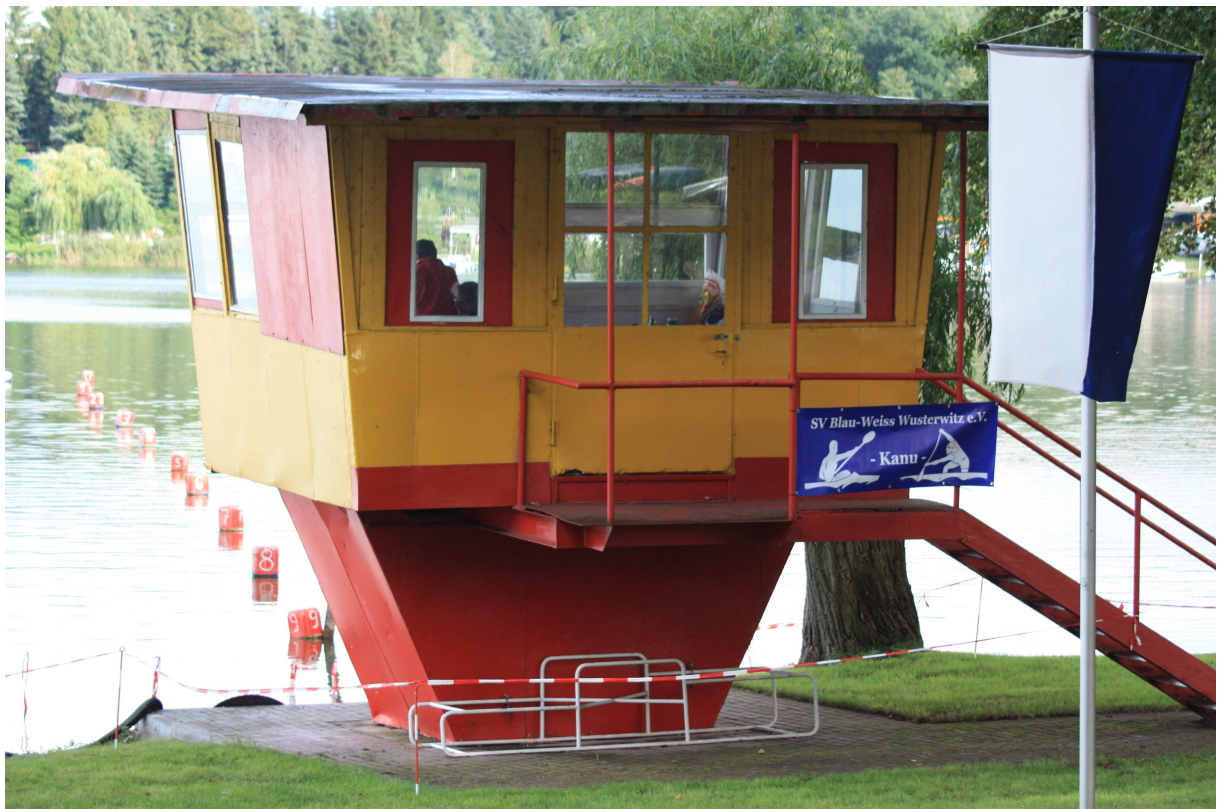
Zielturm an der Wusterwitzer Regattastrecke, Errichtung 1968
